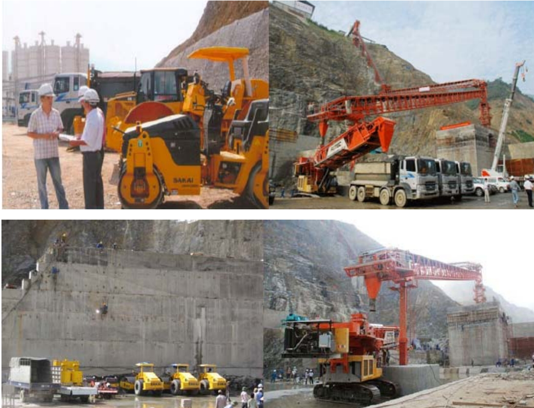
Hình 4: Đầu tư máy móc, thiết bị thi công bê tông RCC
