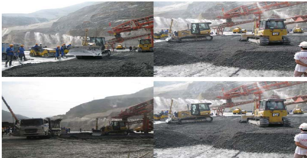
Hình 1: Tổ chức thi công bê tông RCC
