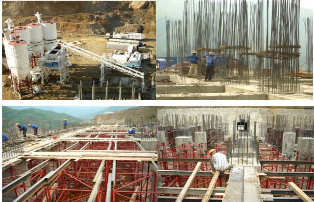
Hình 6: Tổ chức thi công thân đập bằng bê tông RCC
