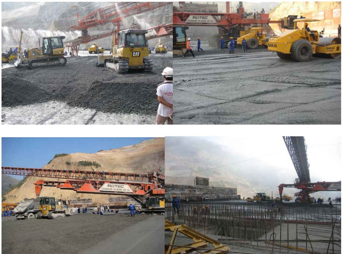
Hình 6: Tổ chức thi công thân đập bằng bê tông RCC
